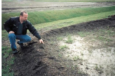
Berma de composta para estabilizar el sitio.
