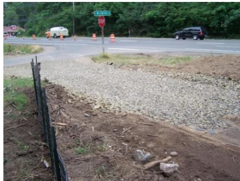
Entrada al sitio con grava.
